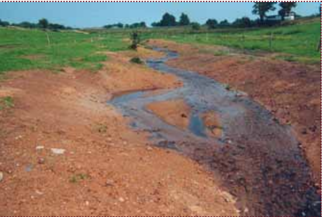
Aufwertung Gewässerbett mit unbefestigten Ufern Foto: KÜHFUSS, LandschaftsArchitektur* Umweltplanung Dresden
