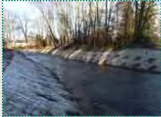
Raue Rampe nach Beendigung der Baumaßnahmen (Foto: Dr. Stefan Sieg)
