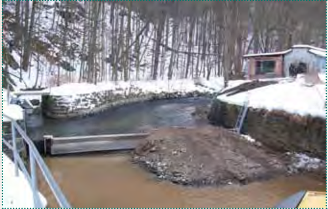
Umgestaltung Wehranlage bei Baubeginn, ENSO-Wasserkraftanlage Rote Weißeritz (Foto: Dr. Stefan Sieg)
