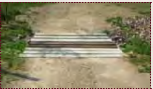
Furt nach der Fertigstellung Quelle: ÖkoProjekt ElbeRaum GmbH Dresden
