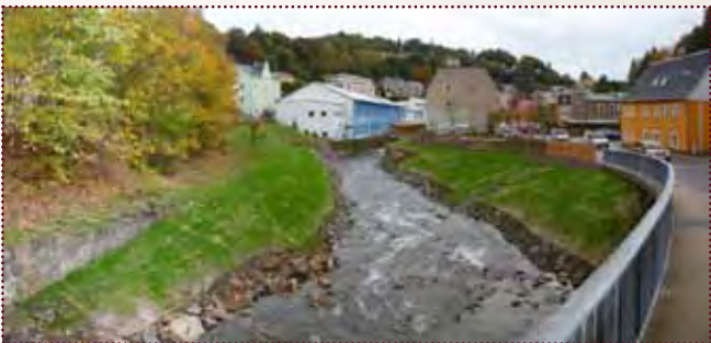
Neu gestalteter Gewässerabschnitt nach dem Abbruch der Wasserkraftanlage Quelle: Planungsgesellschaft Scholz + Lewis mbH Dresden, Steve Kobsch, Tel. 0351-2168345
