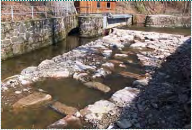
Raugerinne-Beckenpass in Wehranlage integriert, ENSO-Wasserkraftanlage Rote Weißeritz (Foto: Dr. Stefan Sieg)
