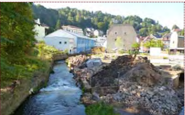
Während der Baumaßnahmen Quelle: Planungsgesellschaft Scholz + Lewis mbH Dresden, Steve Kobsch, Tel. 0351-2168345
