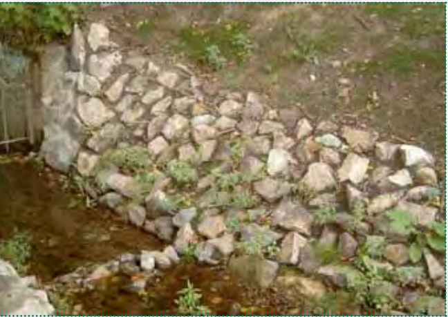
Naturnahe Uferbefestigung mit lockerem Steinsatz und Weidensteckhölzern (Foto: Stadt Freital)
