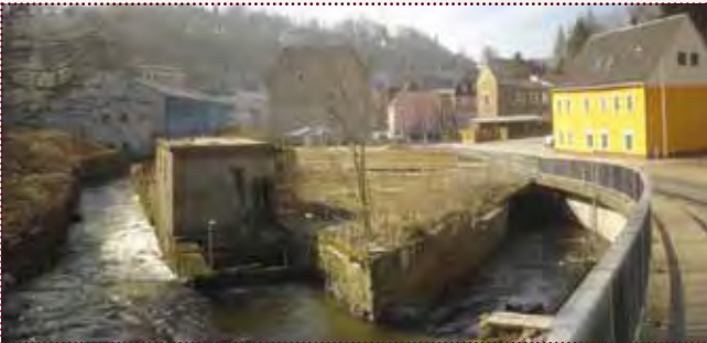
Wehranlage mit Wehrinsel nach dem Abbruch des Turbinenhauses und der Nebengebäude Quelle: Planungsgesellschaft Scholz + Lewis mbH Dresden, Steve Kobsch, Tel. 0351-2168345
