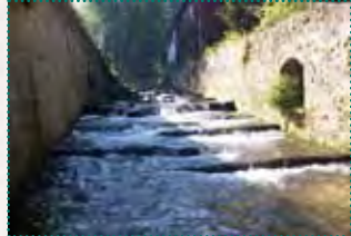
Raugerinne-Beckenpass an der Felsenmühle nach der Umgestaltung (Foto: Dr. Stefan Sieg)
