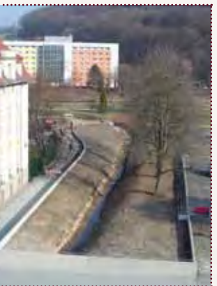
Offenlegung verrohrter Bachlauf und Entsiegelung ehemaliger Parkfläche zwischen Straße und Einmündung in die Weißeritz (Foto: Landschaftsarchitekturbüro Grohmann Dresden)
