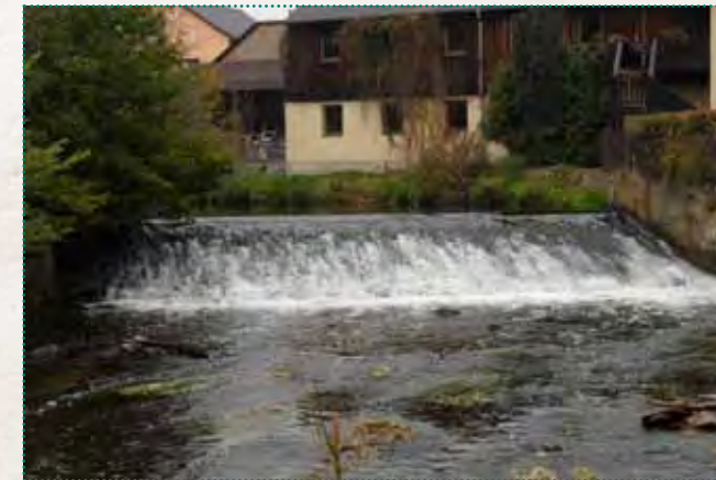
Unterbindung der Fischwanderung und des natürlichen Geschiebetransportes in Längsrichtung des Gewässers durch eine Wehranlage, (Foto: LPV Sächsische Schweiz-Osterzgebirge e.V.)
