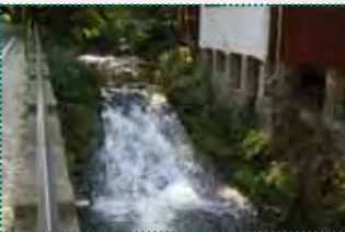
Wehrabsturz an der Felsenmühle, Kirmitzschtal vor dem Umbau (Foto: Dr. Stefan Sieg)
