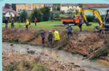
Verbesserung der Gewässerstruktur an einem Bachlauf Anwendung ingenieurbioologischer Bauweisen
